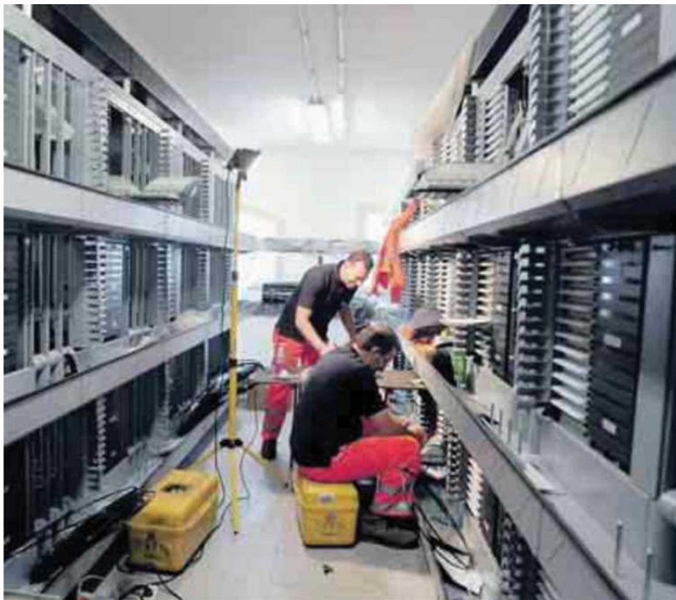
Una centrale in fibra ottica di Telecom
